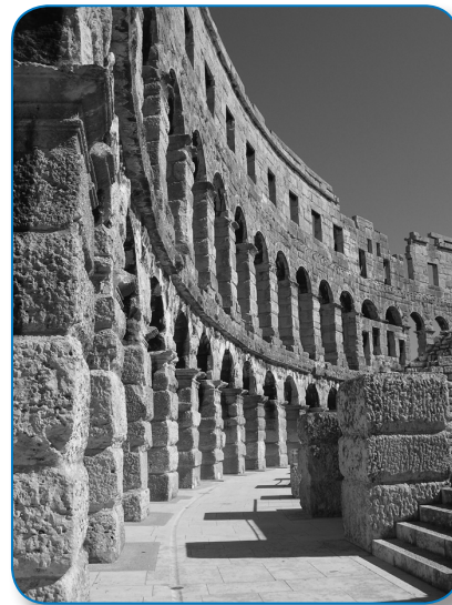
Pulska Arena, pogled izbliza.
